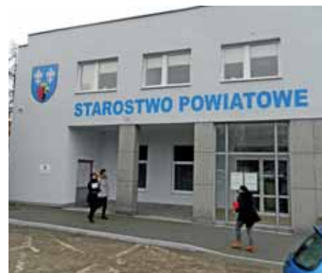
Do nowego budynku przeprowadzi się wkrótce wydział komunikacji i dróg
